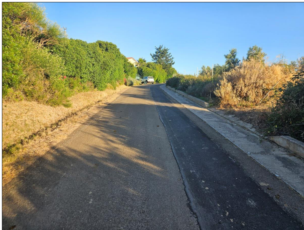
Vista del tratto di "Setzu - Genuri" oggetto di intervento
