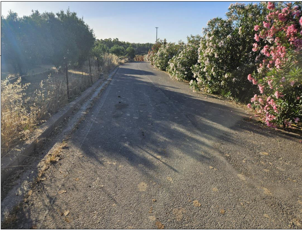
Vista del tratto di "Setzu - Baradili" oggetto di intervento
